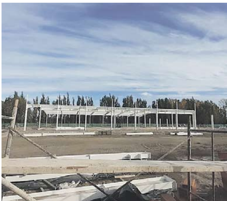
Las estructuras del supermercado que ya levanta La Anónima en Fernández Oro.
