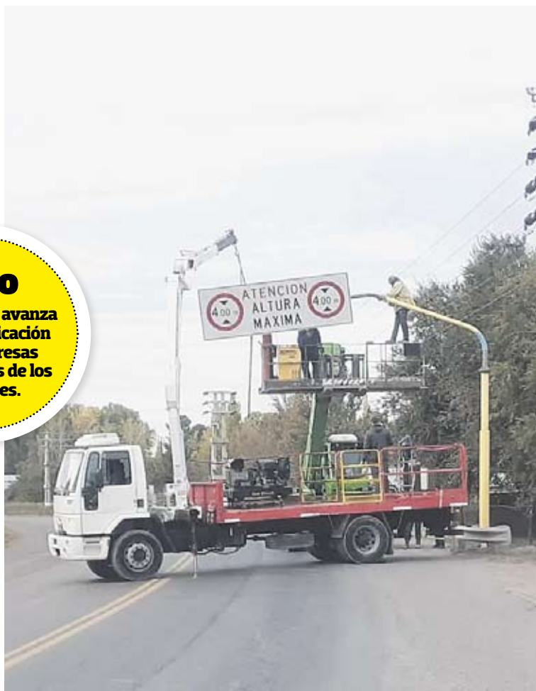
Los trabajadores municipales realizaron los trabajos de señalización.
