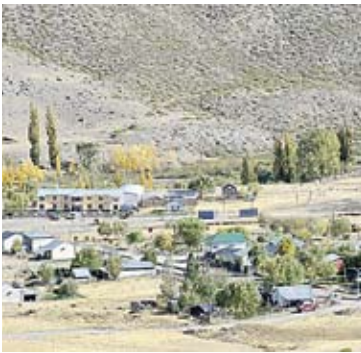
El tendido de gas en Los Guañacos se habilitará este viernes.
