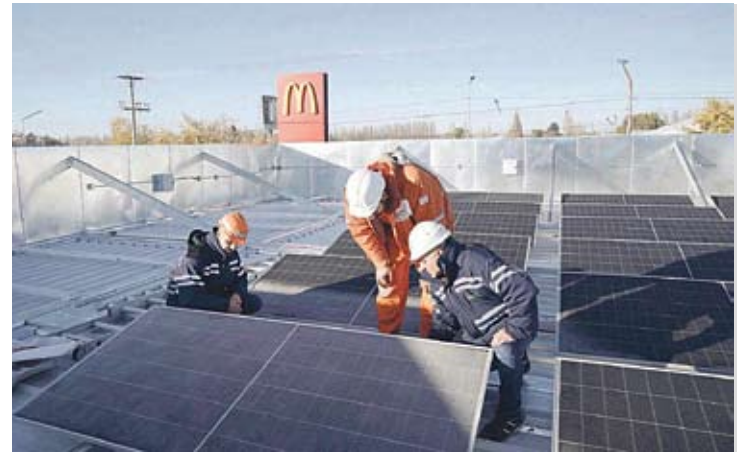
Personal de Calfrenova, instalando los equipos.
