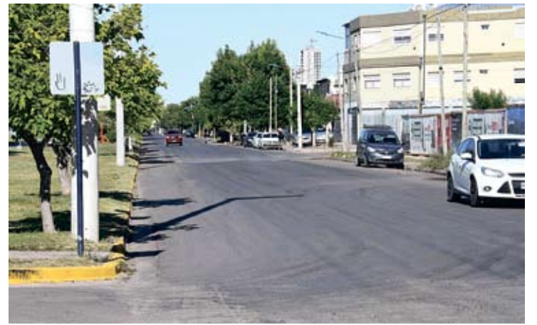
Los trabajos se extienden a lo largo de toda la calle.
